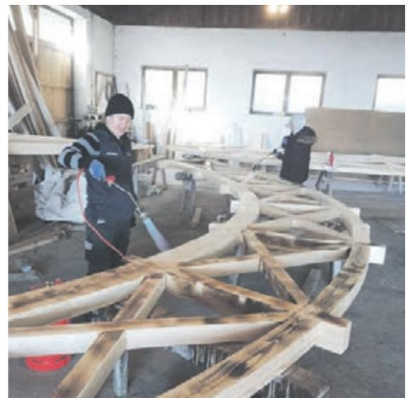
In der Zimmerei von Reinhard Eberl wurden die Brückenteile mit einer Spannweite von 6,80 Meter und einer Höhe von fünf Metern aus heimischem Fichtenholz gebaut.
